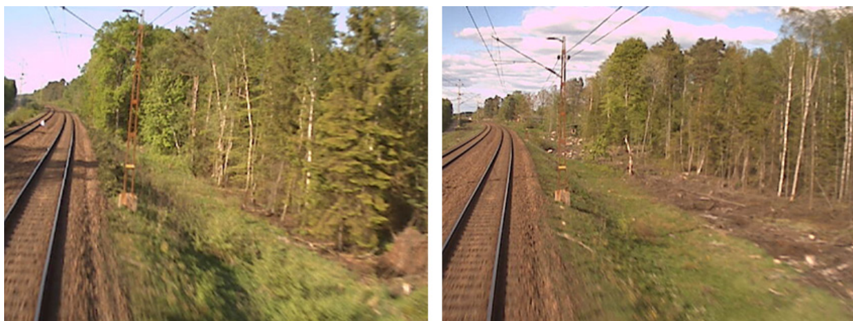
Figur 1: Före- och efterbild på trädskräns genom utvidgning av skötselgatan med tio meter. Foto: Trafikverket (Infranord)
