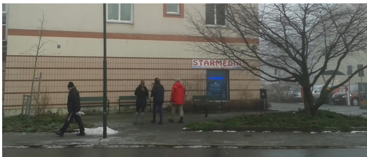
Bild 1: Väggen före installation av systemet.
