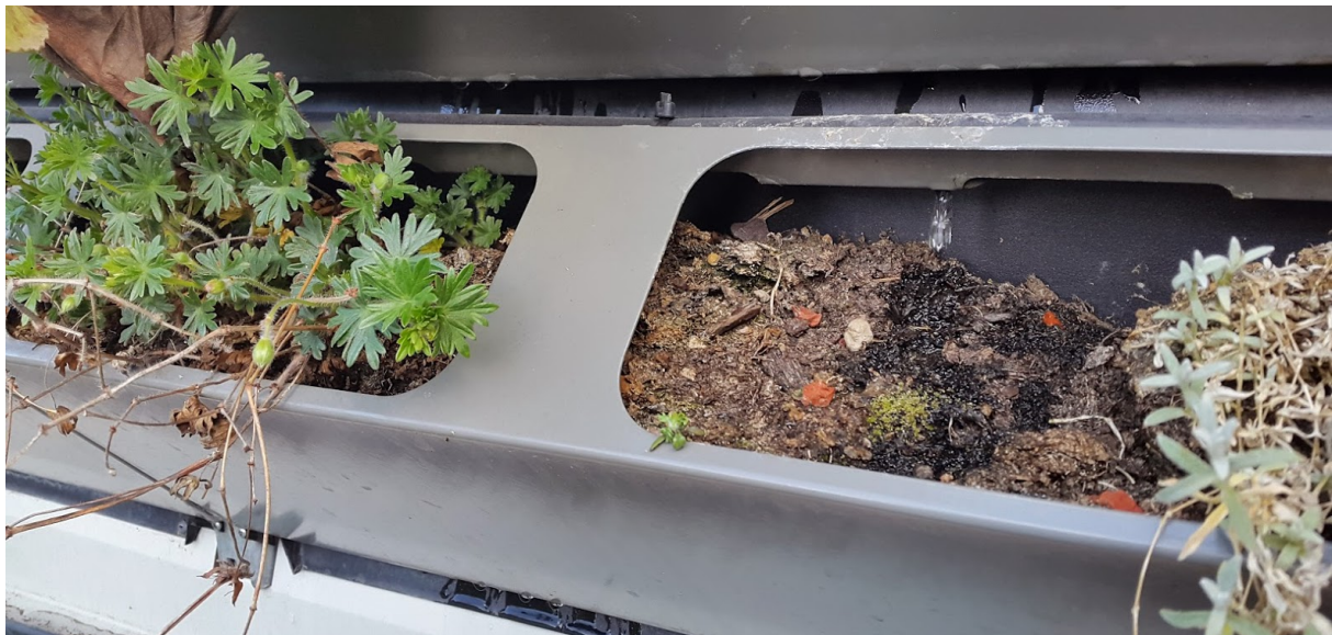
Bild 3: Detaljbild på substrat och bevattningssystem. Bevattningen är igång och vatten droppar ner på substratet.
