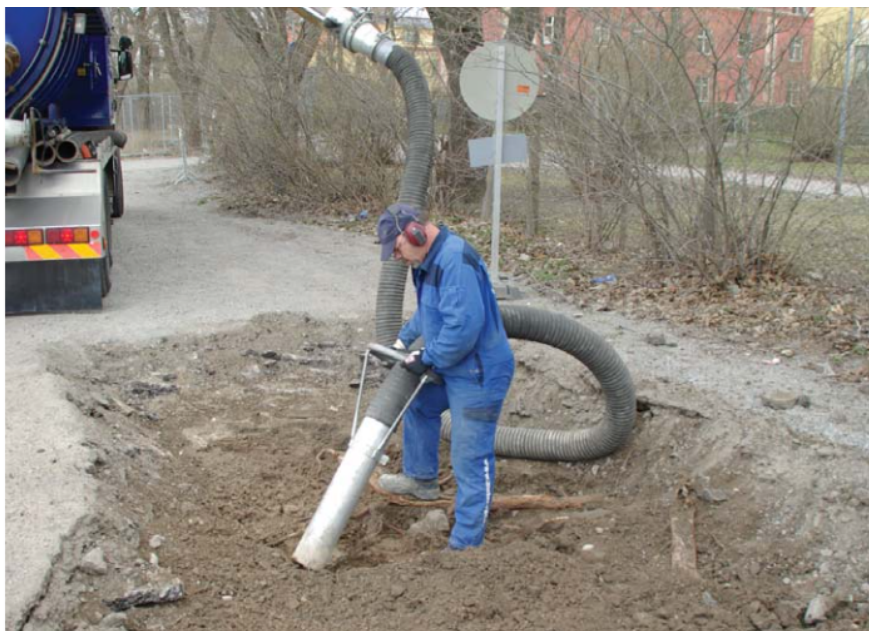
Vakuumschakt vid en rotkartering.
